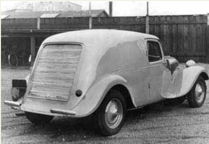
Prototype nummer 2, som er identisk med den første serie varebiler frem til april 1952. Jalousi-bagdøren var frem for alt billig at lave, men fungerede dårligt og blev meget ofte udskiftet til en almindelig, sidehængslet dør. Finish'en på bilerne lod en del tilbage at ønske...
